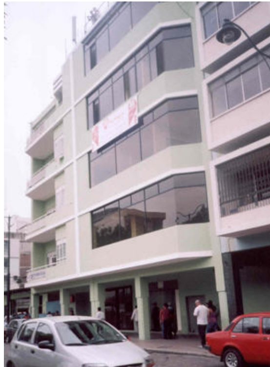
Nuevo edificio en Guayaquil
